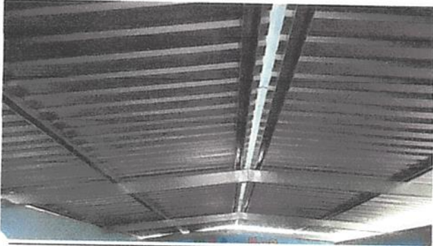
Sustitución de lamina normal por lamina troquelada alusin calibre # 26.
