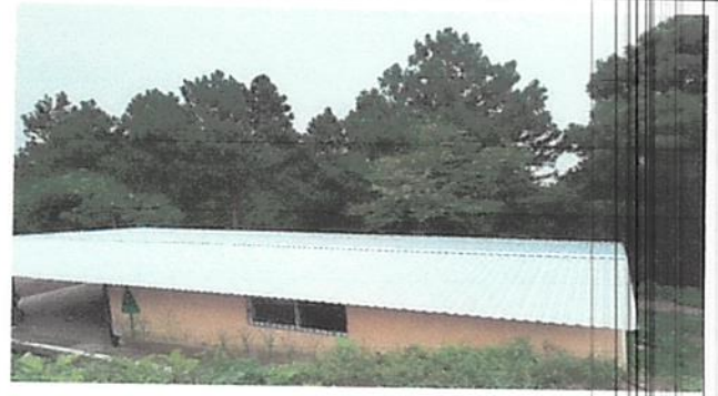
Desmontaje de lamina y estructura.
