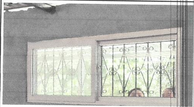
Sustitución e instalacion de ventana.
